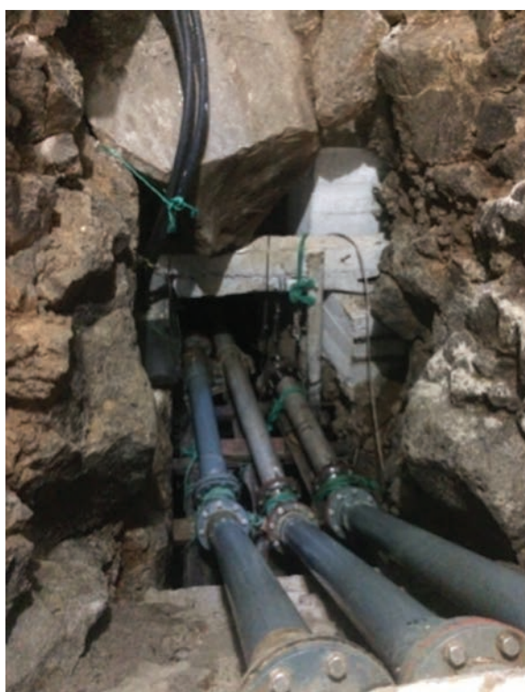
Figura 15.1. Sistema de bombeo y desalinización de agua subterránea salobre mediante ósmosis inversa en Santa Cruz Galápagos.
