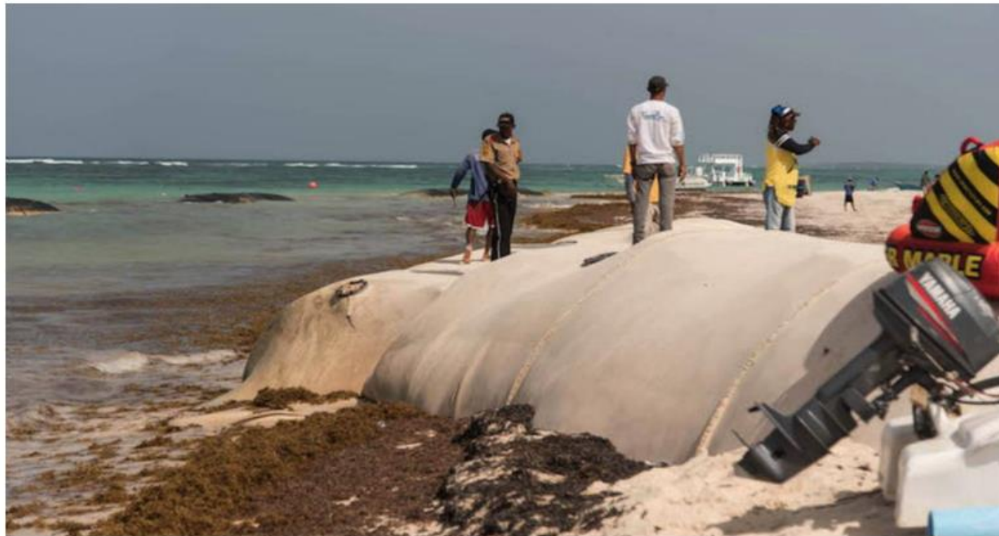
Un geotubo instalado por hoteleros para retener la fuerza del oleaje. Marvin del Cid - CPI
